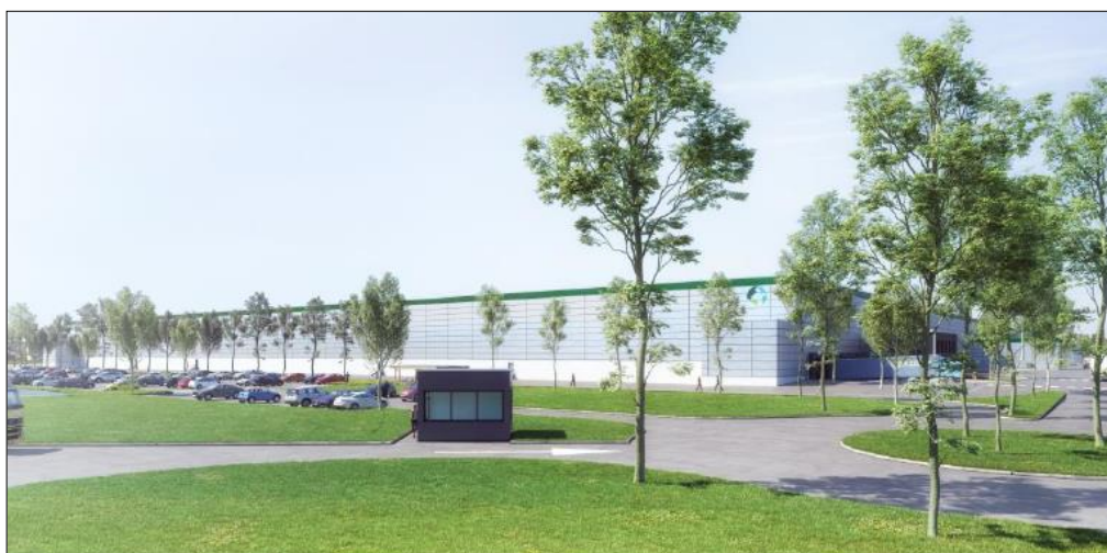
Figure 10 : Vue virtuelle de l'entrée sud-ouest du site
